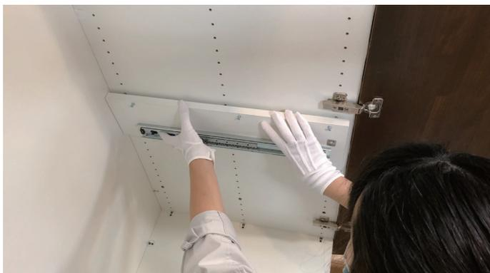
②システム収納へ側板（右・左）を取付けます。
