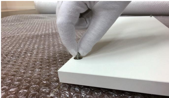
①側板 2 枚にあるダボ穴にダボ金物をねじ込みます。
