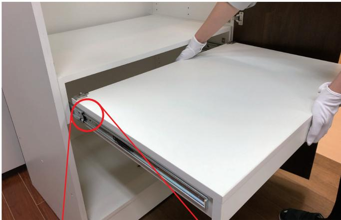
⑥側板のレール（スライドレール外）とスライドデスクのレール（スライドレール内）をはめ合わせます。レールの高さを合わせ、スライドデスクを押し込みます。この作業は二人以上で行って頂くと安全です。
